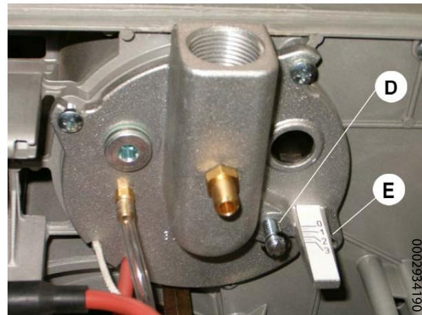
D - Винт регулировки диска пламени
