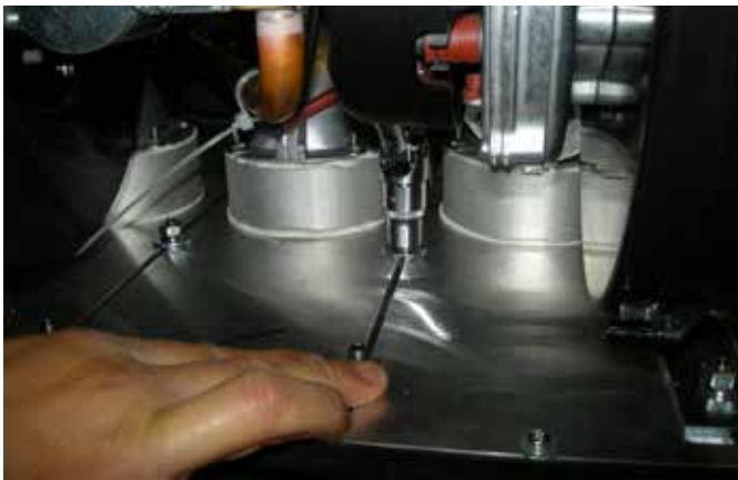
- Снять винты "А" с каждого элемента (торцевым ключом размером 13 мм)
